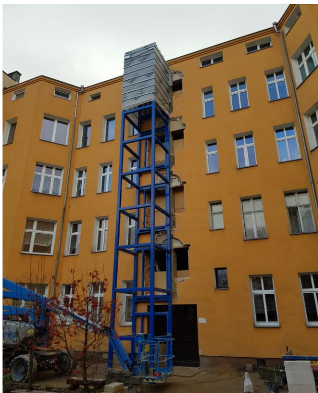
Figure 1. Montaż szybu windowego
