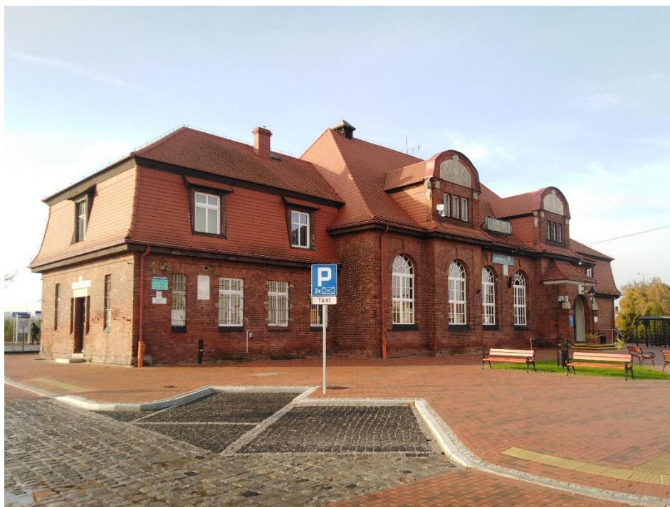
Rysunek 4. Zdjęcie dworca kolejowego w Tucholi z 2020 roku – widok na elewację frontową
