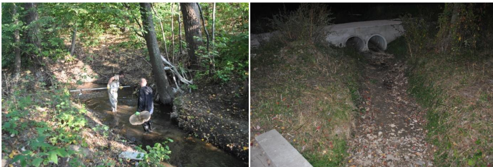
Rycina 8 i 9. Potok Małochlebówka stanowi siedlisko bytowania ryb jedynie w odcinku przyujściowym w pobliżu Wątku. Odłowy ryb do celów naukowych w Małochlebówce przy wiadukcie kolejowym w Tarnowie N50°01'119'', E021°01'806'' (fot. S. Klich, 16.09.2011r.). Obok całkowicie wyschnięte koryto Małochlebówki w Tarnowie w Lasku Lipie około 4 kilometry powyżej jej ujścia do Wątku (fot. M. Klich, 02.10.2011r.)
