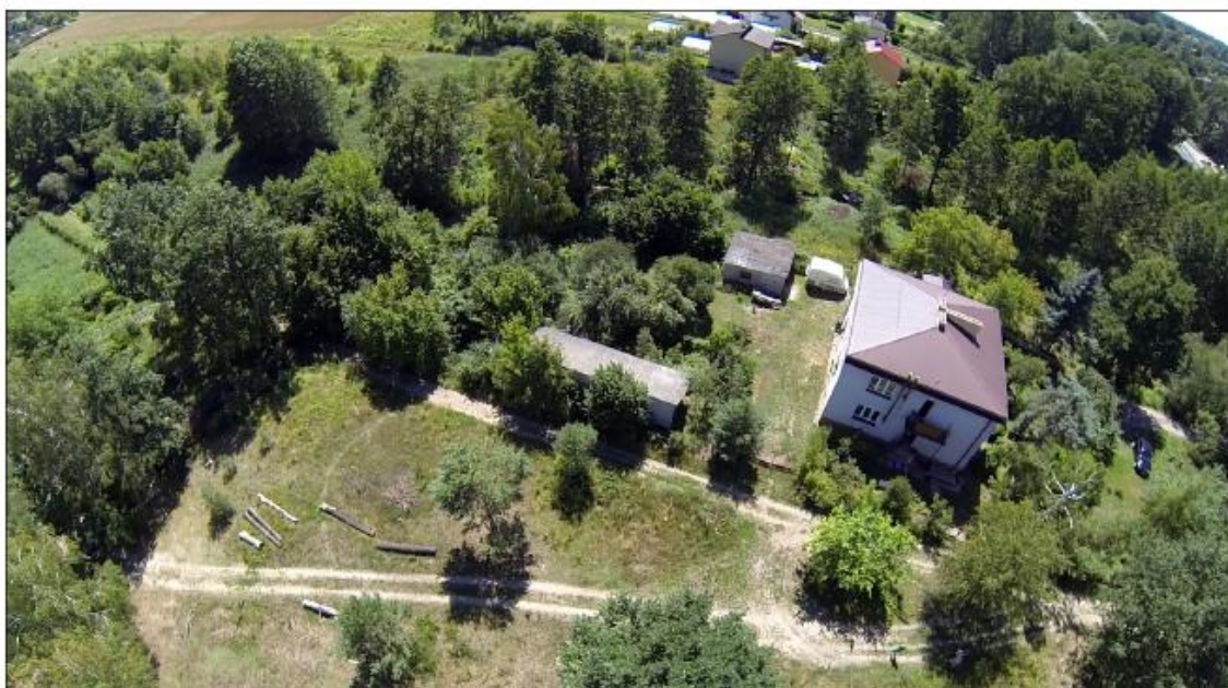
Ryc. 9. Rajec Poduchowny. Fotografia lotnicza wykonana z drona, z użyciem kamery GoPRO (fot. M.Wójcik, D. Piasecki)
